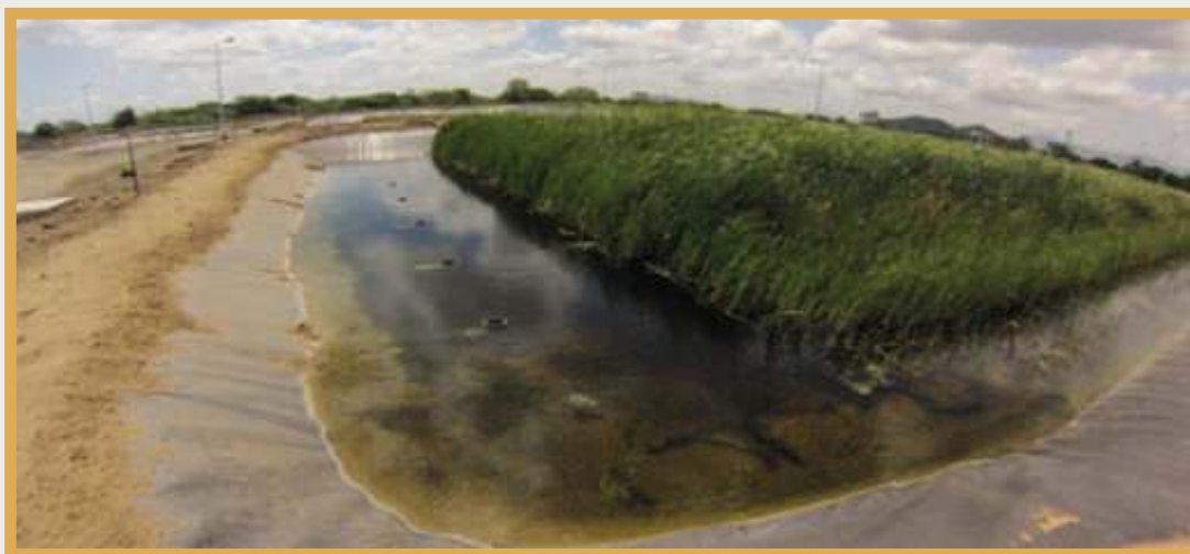
Zone humide d'épuration construite au parc industriel de Caracol à Caracol, NE Haïti
